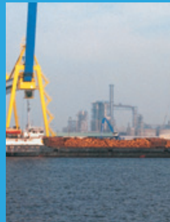
Das Europawerk EGGER in Wismar setzt hinsichtlich Kapazitäten, Logistik und Umweltschutz ganz neue Maßstäbe.
