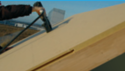
Befestigung mit Breitrückenklammern
